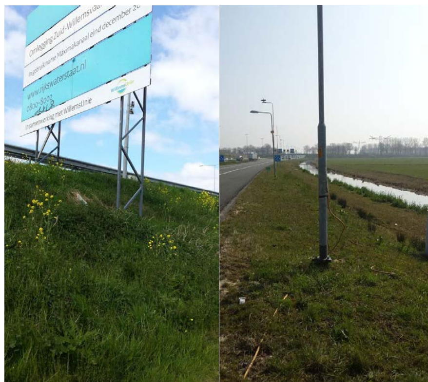
Foto: Tijdelijke bewegwijzering alsmede nieuw, permanent wegmeubilair en verlichting. Er dient te worden onderzocht of deze door de isolerende constructie zijn aangebracht.
